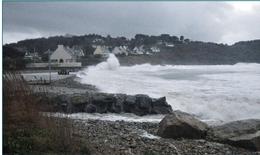
Tempête du 10 février 2020, marée de coefficient 106, Moulin de la rive à Locquirec
